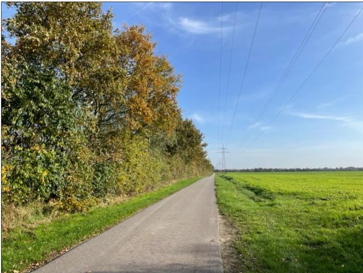
Abb. 5: Typischer Knick (HWy) an der nördlichen Grenze der Sonderfläche 2 (SO-PV 2) mit 110kV-Freileitung (Blickrichtung Osten, 20.09.2022)
